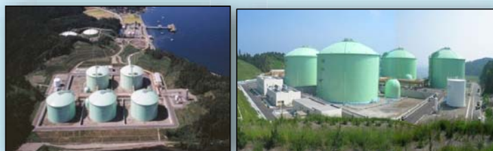
七尾国家石油ガス備蓄基地（石川県）
