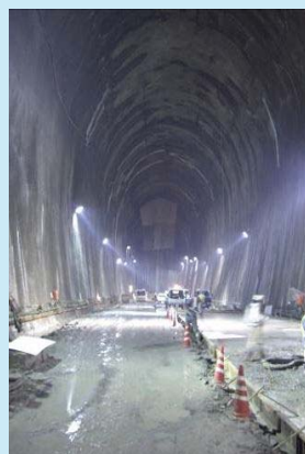
倉敷基地地下貯槽の様子 (建設時) ※2
