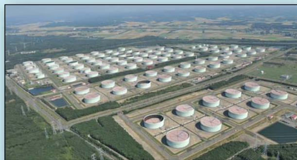
苫小牧国家石油備蓄基地（北海道）
