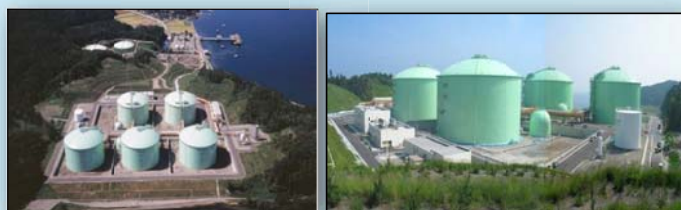
七尾国家石油ガス備蓄基地（石川県）
