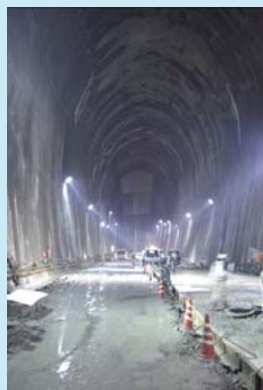
倉敷基地地下貯槽の様子 (建設時) ※2
