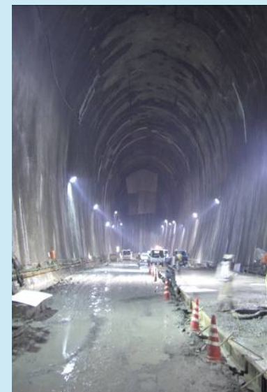
倉敷基地地下貯槽の様子 (建設時) ※2
